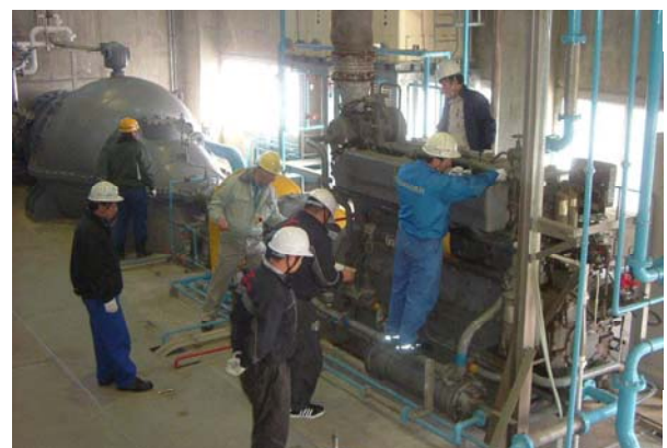
排水ポンプ場（排水機場）の点検
