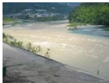
早明浦ダム直下流の状況 (平成17年9月)
