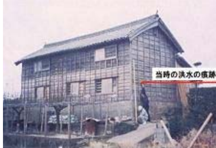
写真 民家に残る大正元年 9月洪水の痕跡
