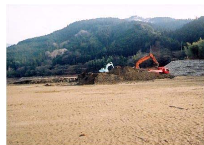
堆砂除去の状況（柳瀬ダム）
