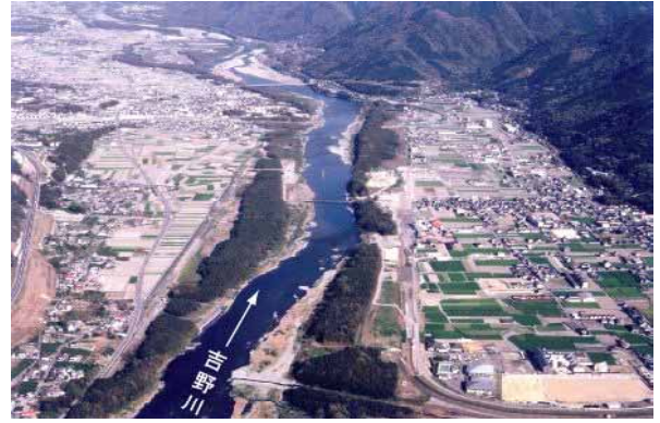
吉野川中流域 太刀野・加茂箇所：河口より64km付近
