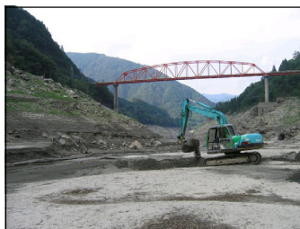
底泥除去（早明浦ダム）
