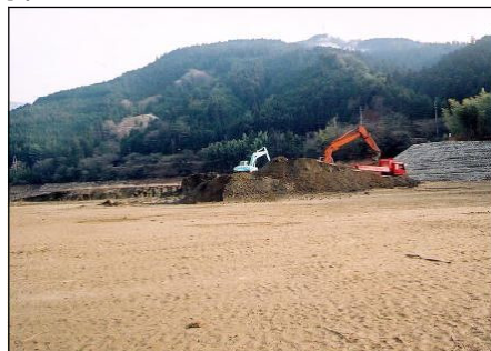
堆砂除去の状況（柳瀬ダム）
