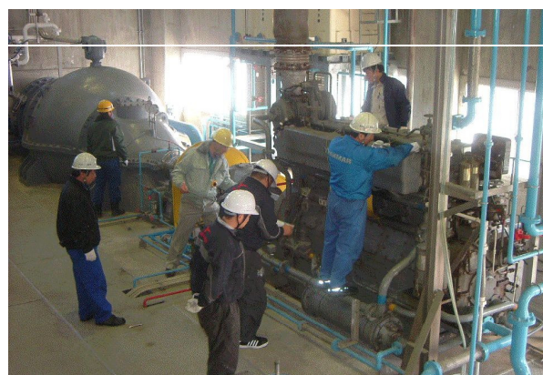
排水ポンプ場（排水機場）の点検
