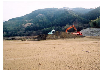
図-50 堆砂除去の状況 (柳瀬ダム)
