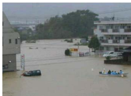
内水はん濫の様子
