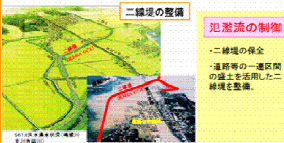
二線堤の整備
