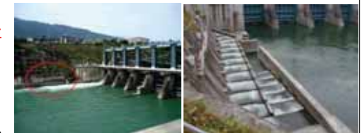
池田ダムの魚道(階段式魚道)
