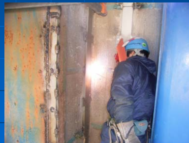
ゲート補修(柳瀬ダム)
