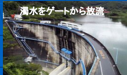
放流設備追加後：濁度分を洪水中に放流
