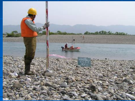
河床変動調査状況(河川横断測量)
