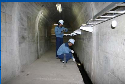
漏水量調査(早明浦ダム)
