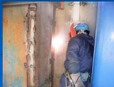
ゲート補修(柳瀬ダム)
