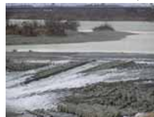
柿原堰の魚道
