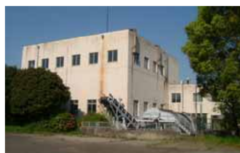
学島川排水機場 吉野川河口から30.4km付近
