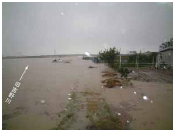
平成16年10月洪水による無堤地区の外水氾濫(鳴門市大麻町) 旧吉野川右岸の河口より7.6km付近
