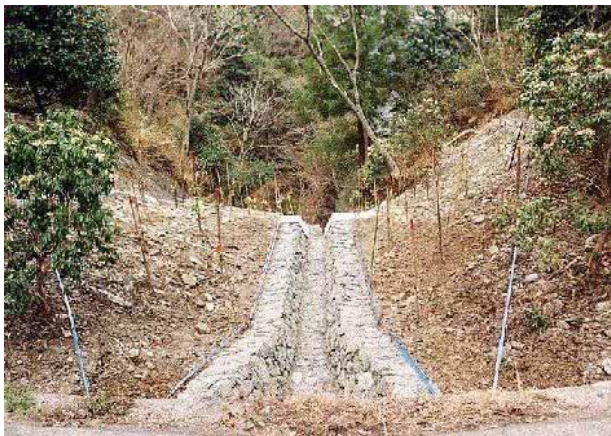
グリーンベルト事業・溪流工（早明浦ダム）
