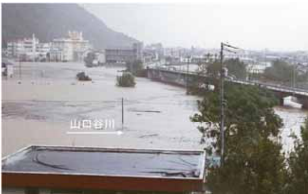
平成16年10月洪水による外水氾濫 (東みよし町)
