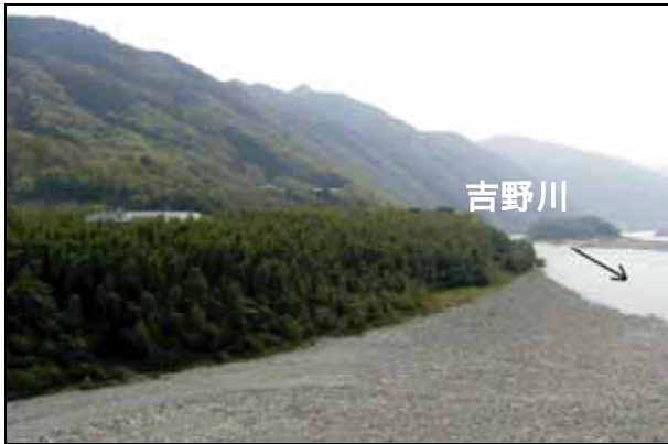
水害防備林(つるぎ町) 吉野川右岸河口より57km付近
