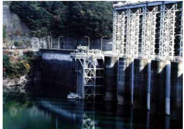
選択取水設備（早明浦ダム）
