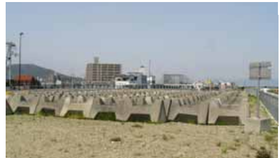
水防資材の備蓄状況
