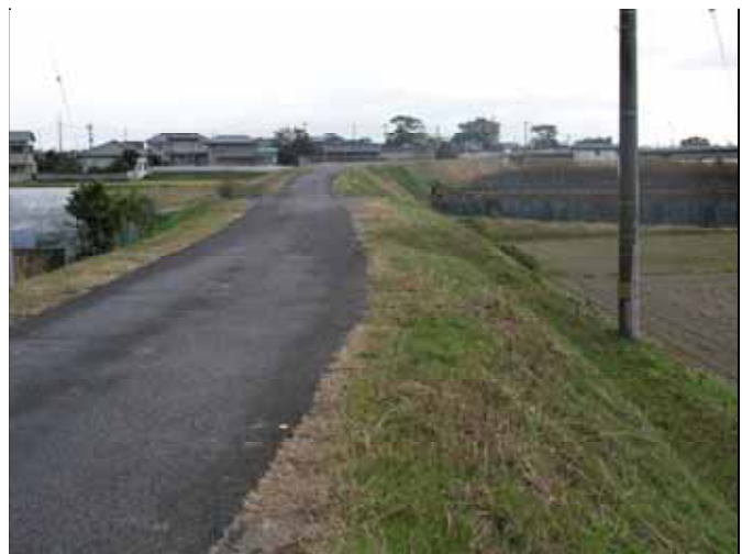
鳴門市大麻町津慈の旧堤防
