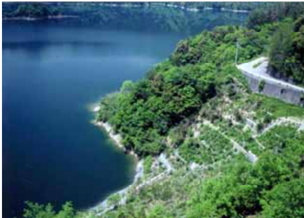
グリーンベルト事業・植栽工（早明浦ダム）
