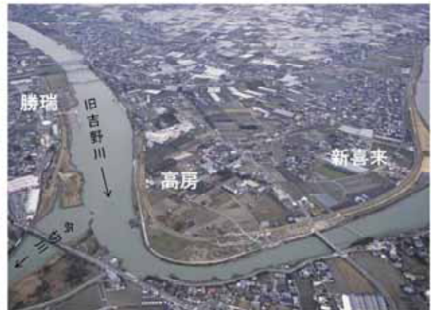
今切川分派点(北島町) 旧吉野川の河口より11.4km付近
