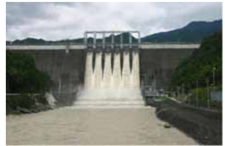
早明浦ダム (平成17年9月洪水)
