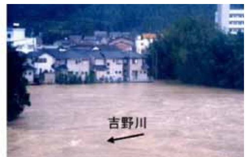
平成16年10月洪水による 無堤地区の外水氾濫(東みよし町)
