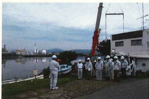
撤去作業写真（徳島市川内町中島地先）
