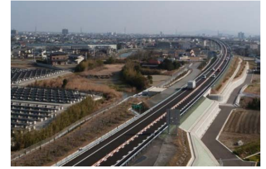
開通後の松茂PA付近
