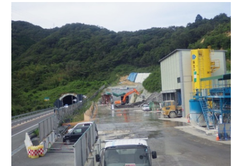
写真2:大坂トンネル工事状況(H27.9)
