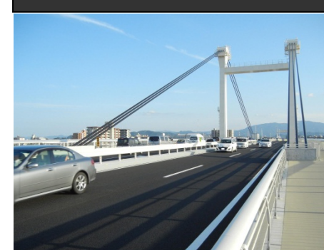
徳島東環状線阿波しらさぎ大橋付近
