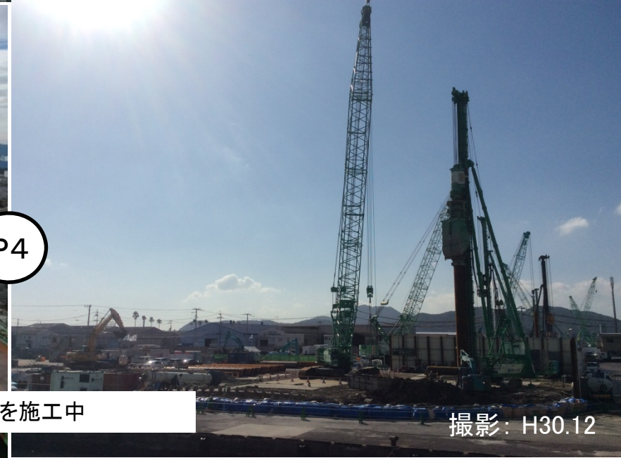
仮締め切り・床掘りを施工中
