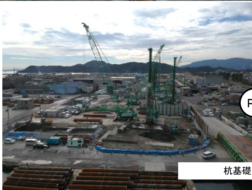
仮締め切り・床掘りを施工中
