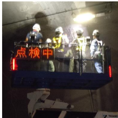
現地実習（打音点検状況）
