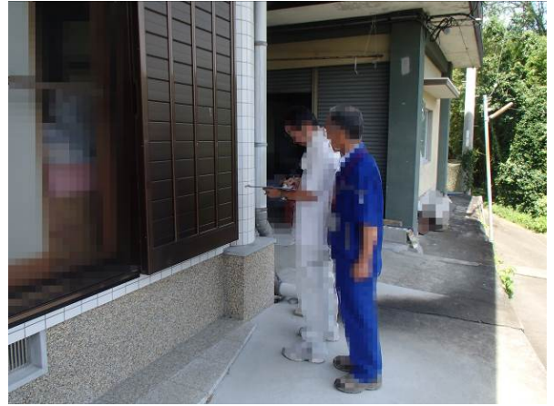
建物調査状況
