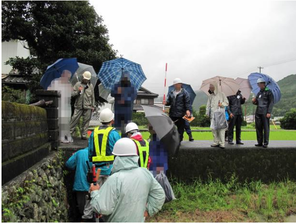
境界立会・用地測量調査状況
