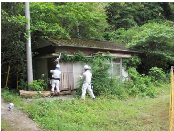
建物調査状況
