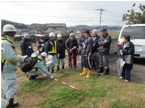
境界立会・用地測量調査状況
