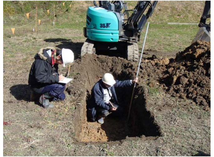
試掘調査状況
