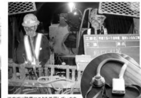
坑内では防塵マスクを着用しています。吸気フィルターから吸った空気が常にマスクから吹き出しています。
