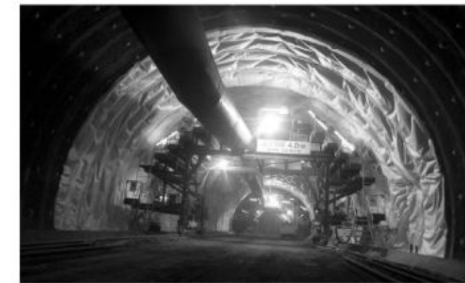
福井トンネルでは、トンネルを掘りながら、壁面の防水シート貼りやコンクリート仕上げを行っています。
