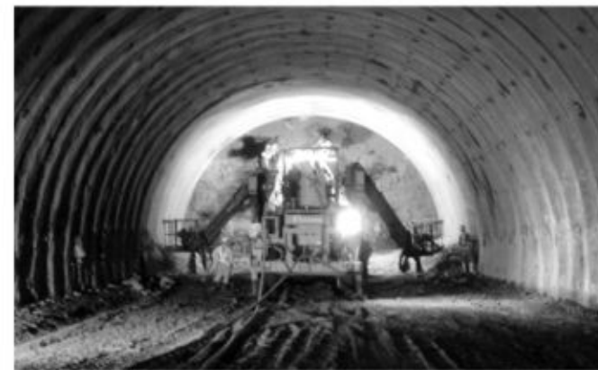
あともう少しで貫通を迎えるトンネル坑内です。
