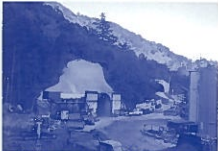
皆さんの目に触れる坑口は、作業用のトンネルの坑口です。
