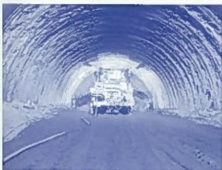
本トンネルは広く、大きな掘削機もご覧のとおりです。
