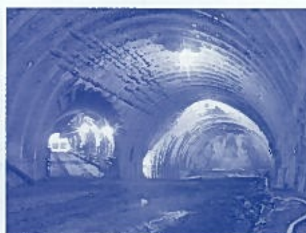
作業トンネルと本トンネルの交差点場所。
