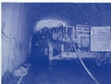
作業トンネルは、本トンネルの半分ほどの大きさです。
