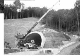
日和佐トンネル(仮称)日和佐側出口の切土盛土
