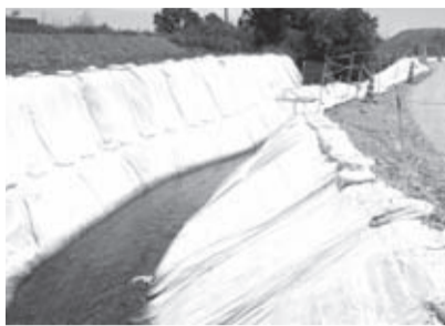
現在の水路。工事中はこんなふうに水路を迂回させ、田畑に水が途切れないようにしているんですよ。
