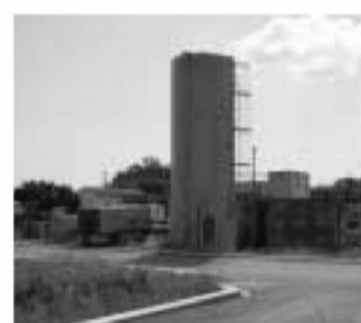
コンクリートミキサー、水槽、ポンプのプラント
