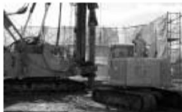
杭は強い力で打ち込まれていく
