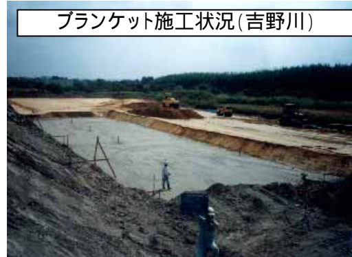
注: 写真のプランケット材料は、難透水性の土質材料
