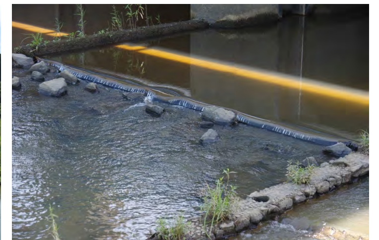
樋門の段差解消
