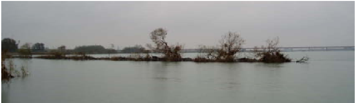
上堰の北側の堰（平成16年10月26日）
