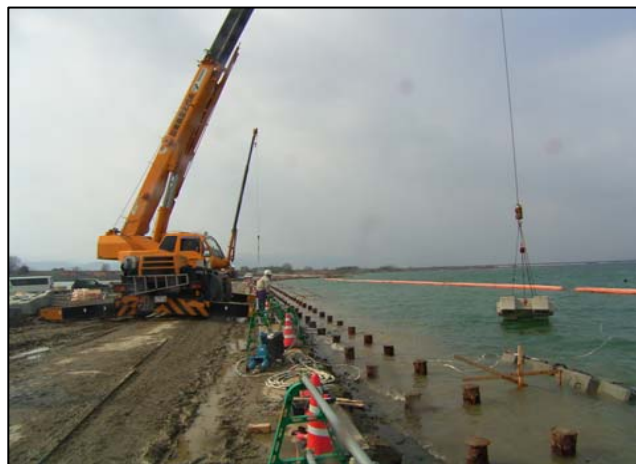
21.根固ブロック据付状況
