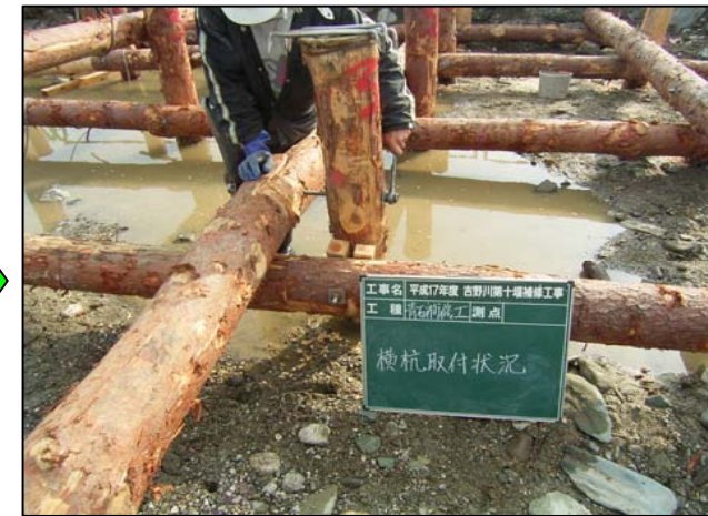
7.杭木・横杭連結状況
