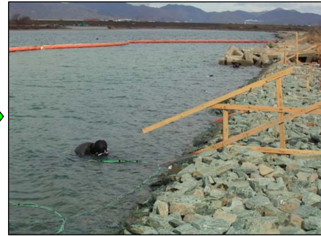
15.根固ブロック据付箇所間詰状況
