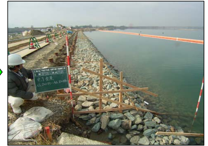
16.根固ブロック据付箇所間詰完了
