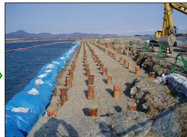
11.杭木・横杭碎石埋め戻し完了
