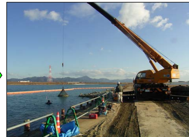
23.袋詰玉石据付状況
