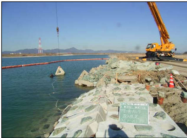
29.中空三角ブロック設置状況
