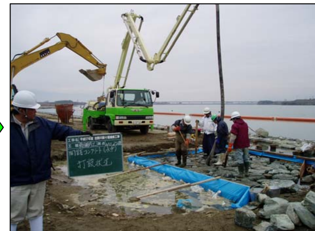
35.コンクリート打設状況
