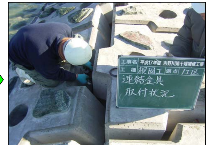
24.根固ブロック連結金具取付状況
