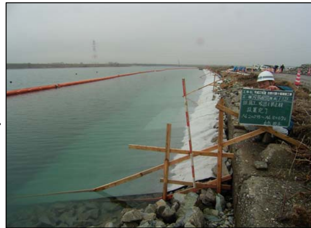
18.吸出し防止材設置完了
