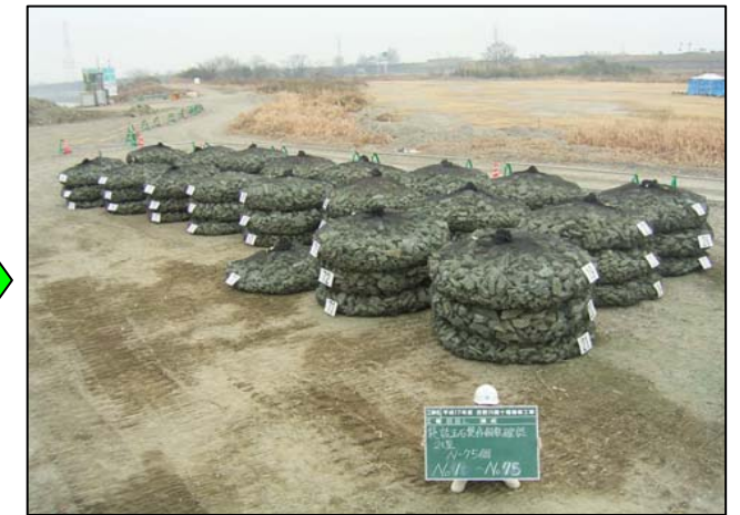
20.袋詰玉石製作完了
