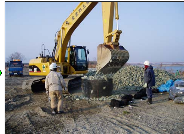
19.袋詰玉石製作状況
