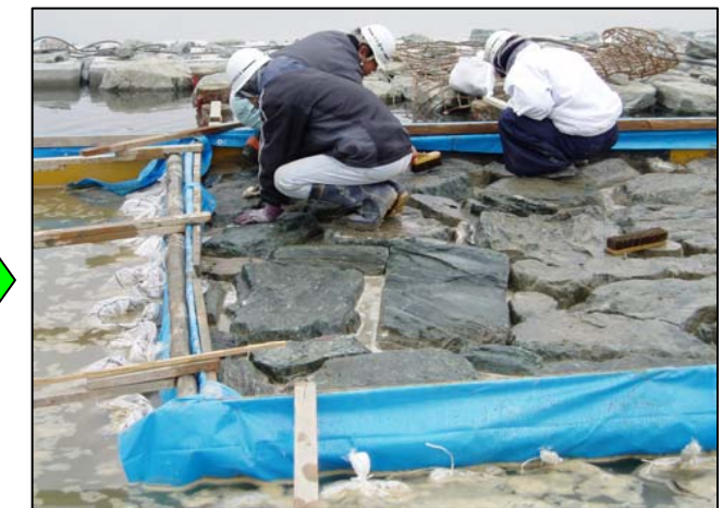
36.コンクリート打設後青石洗浄状況
