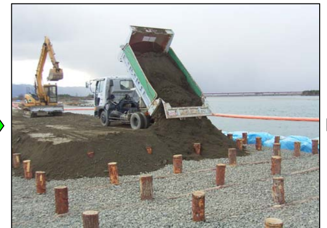
12.工事用道路設置状況
