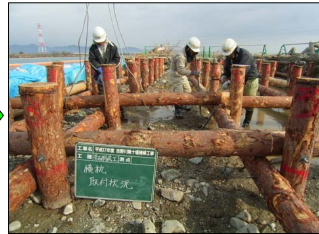
3.横杭取付状況
