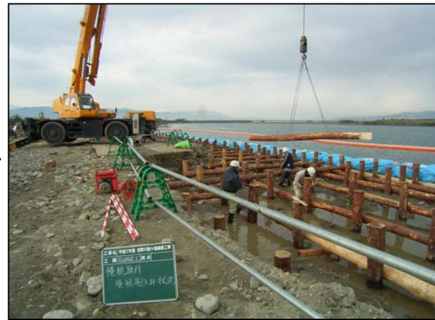
2.横杭吊り込み状況
