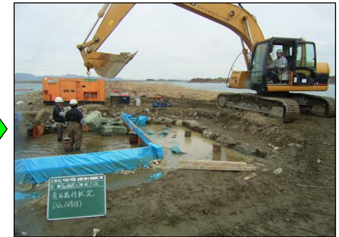
32.青石据付状況
