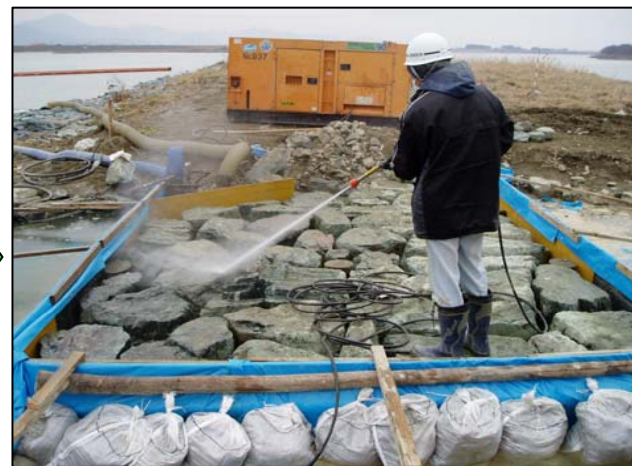
34.コンクリート打設前青石洗浄状況
