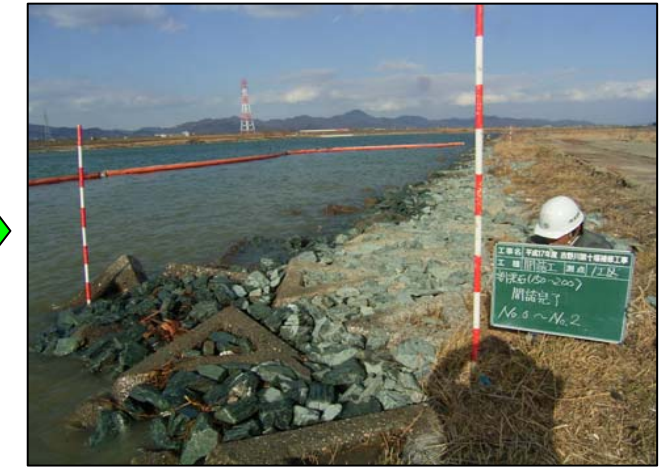
28.割栗石間詰完了
