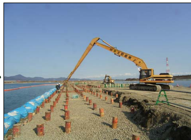
10.杭木・横杭碎石埋め戻し状況
