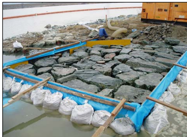
33.青石据付完了
