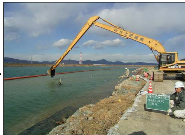
22.根固ブロック法尻部埋め戻し状況
