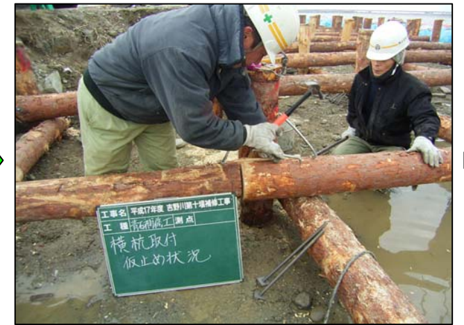
4.横杭仮止め状況
