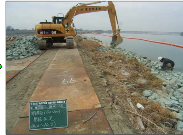
27.割栗石間詰状況
