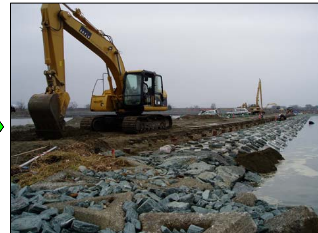
31.青石据付箇所掘削状況
