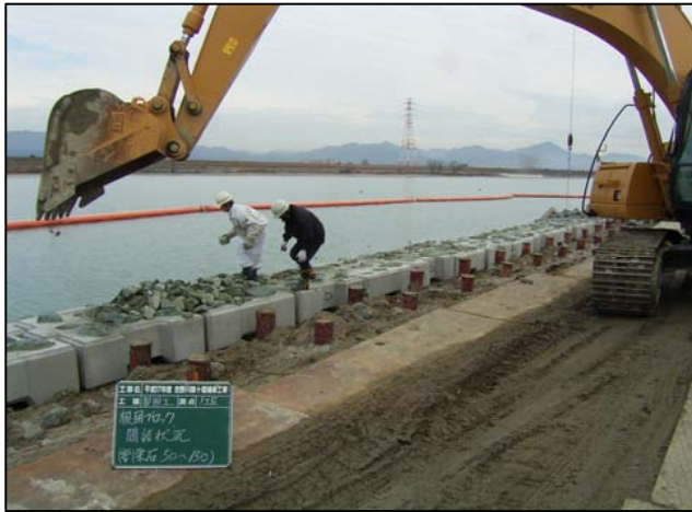
25.根固ブロック間詰状況
