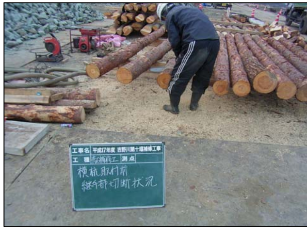
1.横杭継手部切断状況
