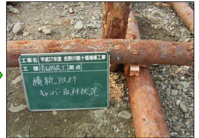
8.杭木・横杭キャンバー取付状況
