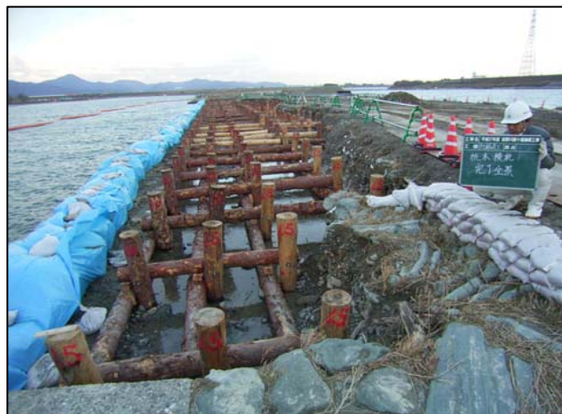
9.杭木・横杭取付完了
