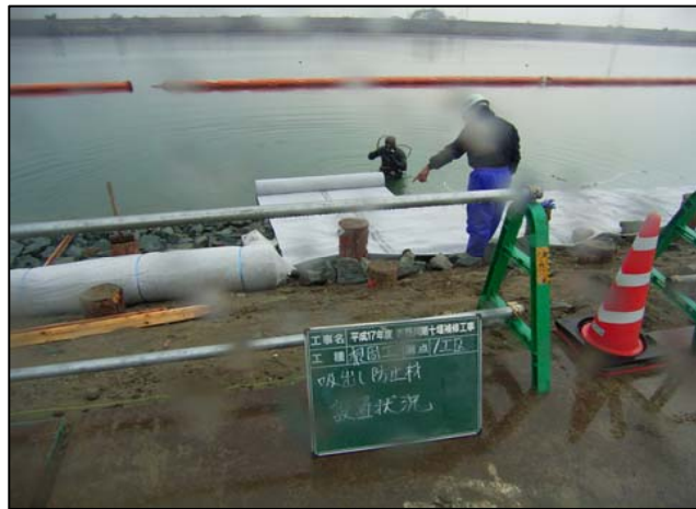
17.吸出し防止材設置状況
