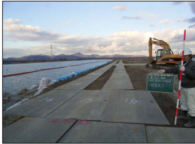
13.工事用道路設置完了
