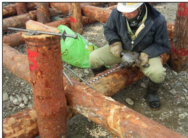
5.杭木・横杭連結用ボルト穴開け状況
