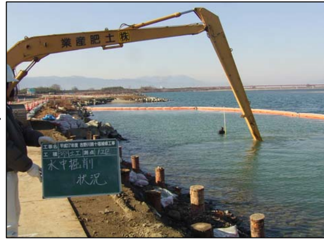
14.根固ブロック据付箇所掘削状況
