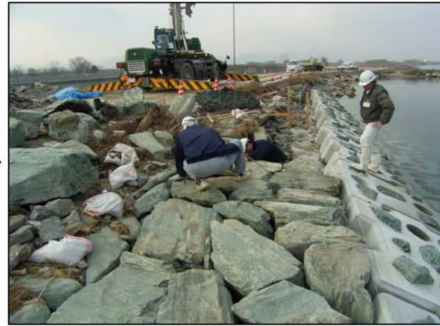
26.捨石設置状況
