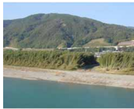
竹林（マダケ群落）の倒伏状況 (63.6k 角の浦大橋上流)
