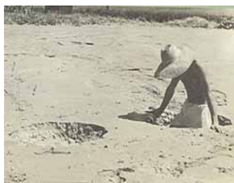
水が地盤に浸透して堤内地の地表にわき上がってできた大穴(ガマ) 1) (昭和29年(1954)9月)
