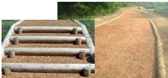
木材チップ舗装の施工例（左：階段，右：舗装道） 木材チップ舗装は天然素材を用いるため、自然環境と調和しやすく、歩行者に快適で安全な道や階段を提供する
