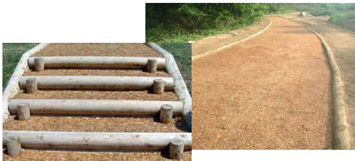
木材チップ舗装の施工例（左：階段，右：舗装道）
