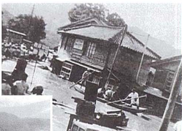
▲ 昭和29年(1954)9月 浸水の様子
