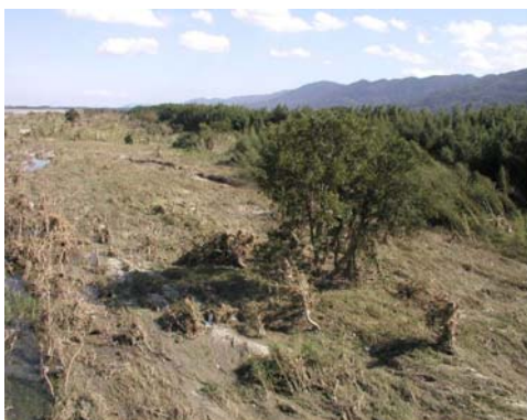
低木類の倒伏状況 (36.0k 瀬詰大橋下流)
