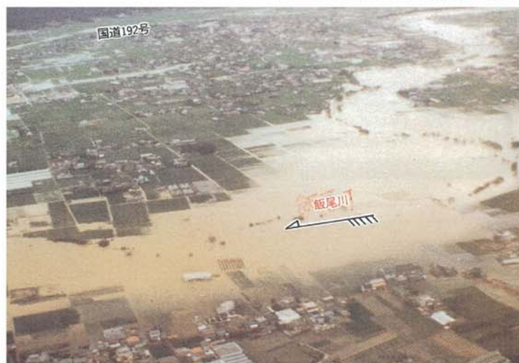
▲ 昭和51年(1976)9月 石井町の内水被害
