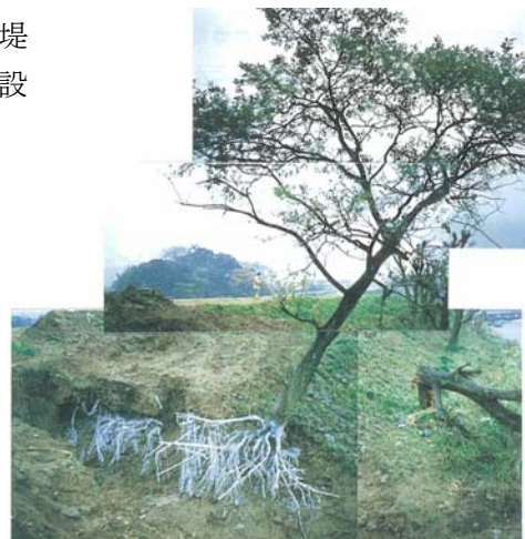
写真 3.1.2 堤防法尻付近に延伸する根系の状況 1)
