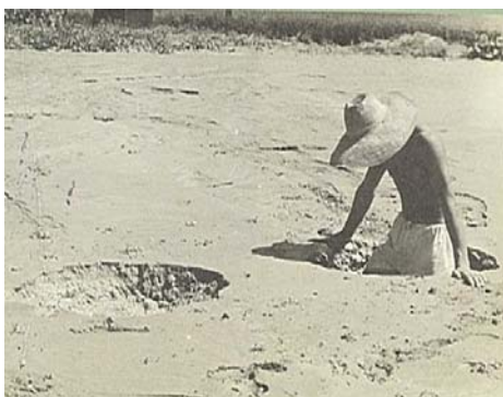
水が地盤に浸透して堤内地の地表にわき上がってできた大穴(ガマ)
