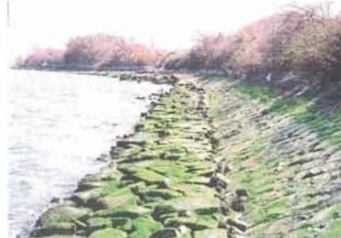
低水護岸と法止・根固の状況
