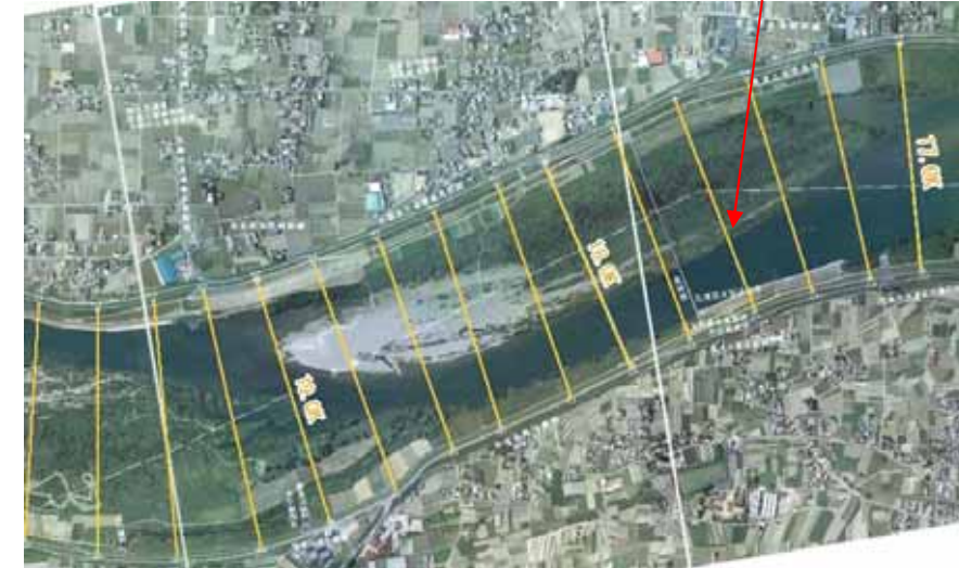
図 - 3.2.3.4 砂州の下流側から進行する樹林 (高瀬橋 17.8k)
