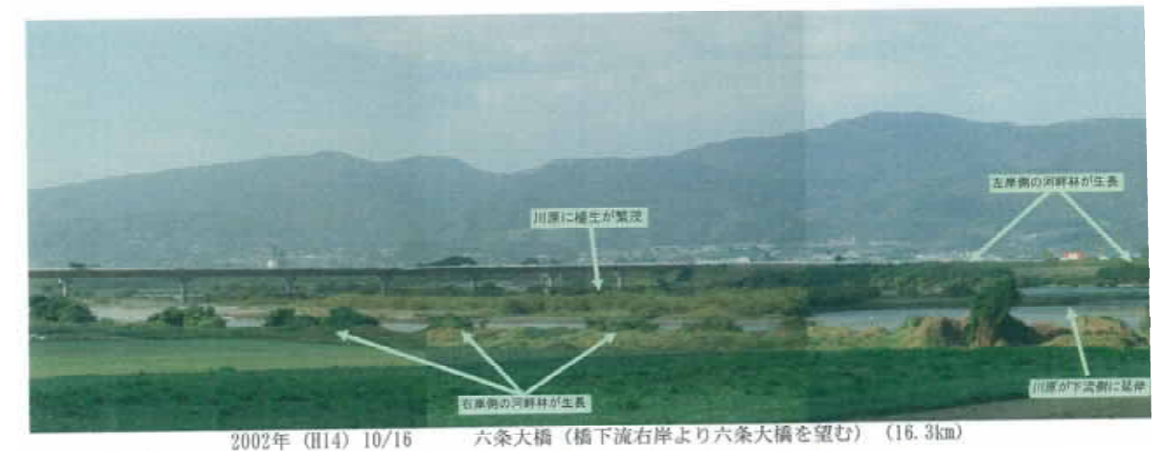
図 - 3.2.3.10 六条大橋(16.3k)下流 樹林化による砂州の礫河原の減少 (H.6 と H.14)
