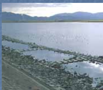
ケレップ水制 (吉野川左岸、藍住町東中富)
