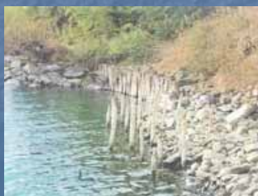
杭出し水制 (吉野川左岸16.2k)
