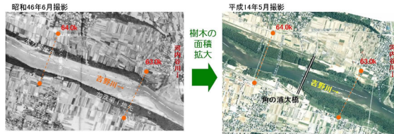
図 3.1.1 樹木の面積拡大状況（角の浦大橋地点 64.0k付近）
