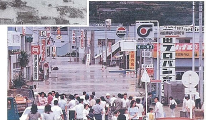
▲ 昭和49年(1974)9月 脇町の無堤区間で氾濫被害 (地点②)
