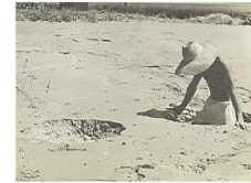
水が地盤に浸透して堤内地の地表に わき上がってきた大穴 (ガマ) (昭和29年(1954)9月)
