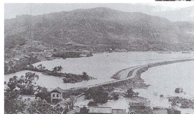
▲ 昭和36年(1961)9月 川島の内水被害 (地点①)
