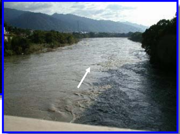
②美濃田大橋 (三好郡井川町、三好町 吉野川 7.1 km 付近)
