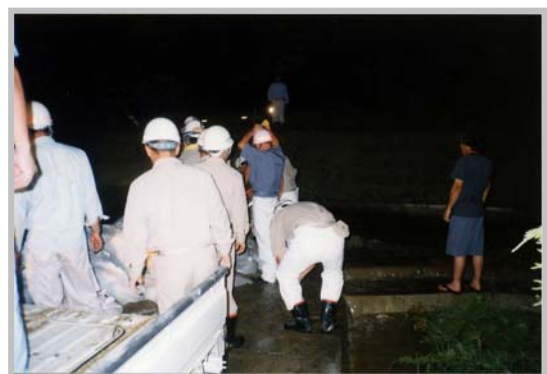
(三好郡三野町水防活動状況)
