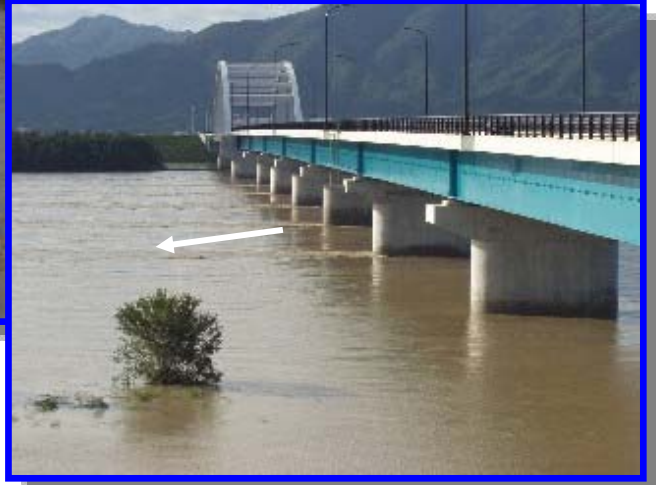
⑦西条大橋（板野郡吉野町 吉野川 2.2 km 付近）
