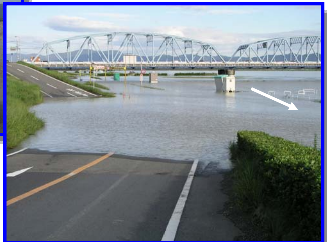
⑨吉野川橋下流河川敷（徳島市上吉野町 吉野川右岸 4 km 付近）
