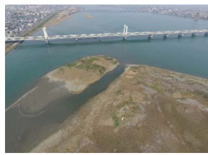
平成27年頃の河口干潟 平成24年に開通した阿波しらさぎ大橋は、斜張橋形式にすることで橋脚の数を減らし、干潟への影響を最小限に抑えるなど、自然環境に配慮されている。
