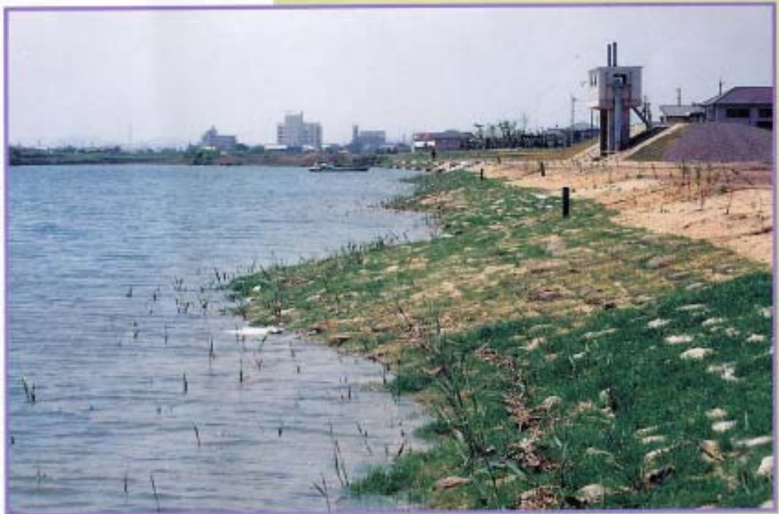
▼ 工事完成後3ヶ月
