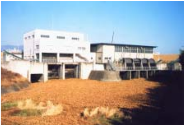
飯尾川排水機場
