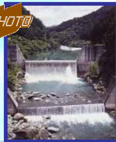
瀬戸川堰堤(瀬戸川)
