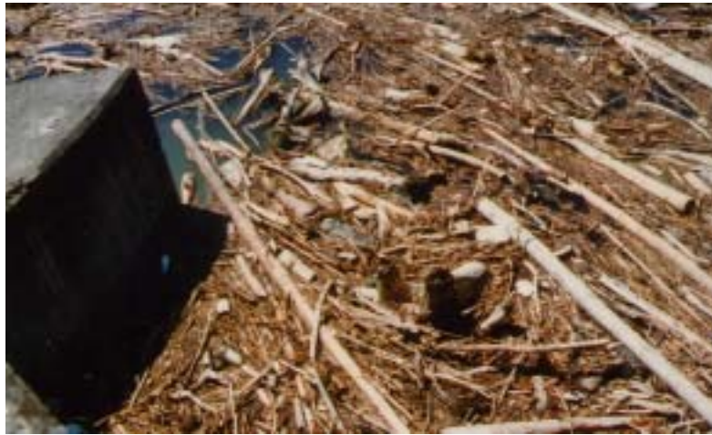
ゲート直上流の流木「放流中」によりゲートに危害の恐れ
