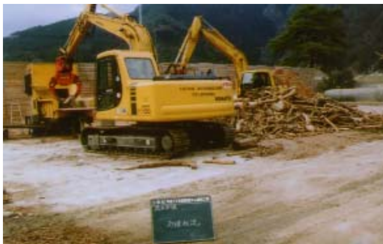
流木のチップ材(燃料・土壌改良材)処理状況
