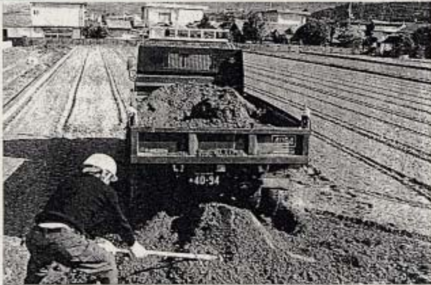
運送業者のトラックで田畑に運び込まれるダム湖の堆積土。伊予三島市豊岡町で
