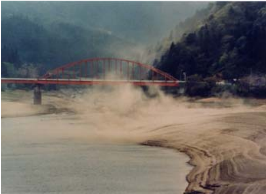
貯水位低下時の砂塵発生状況
