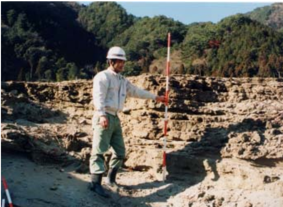
堆砂土砂の堆積状況
