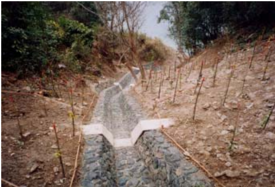
施工後(自然環境を考慮した石張り水路)
