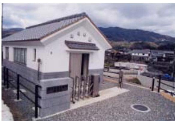
遠方操作室と操作盤
