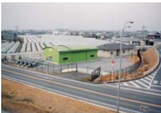
排水機場全景
