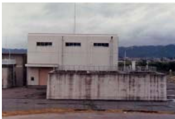
排水機場全景
