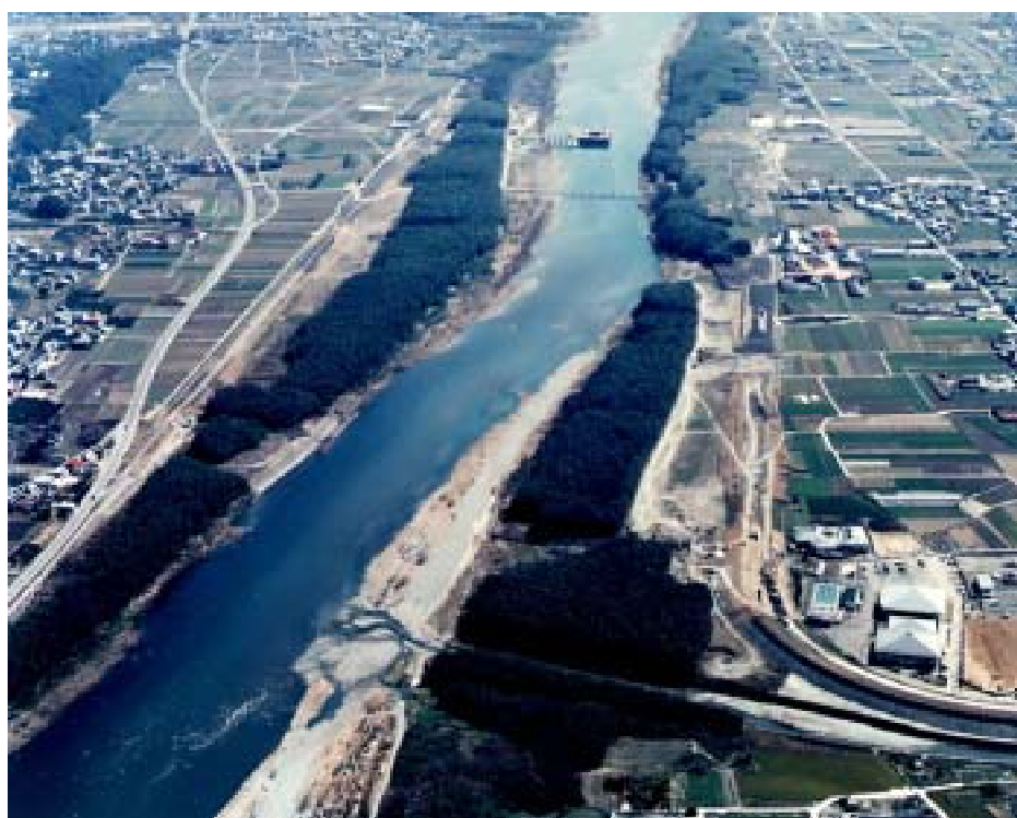
現在築堤事業を実施している三加茂町（右岸）及び三野町（左岸）
